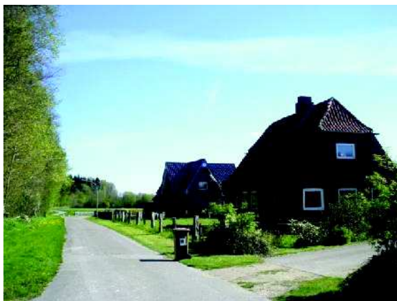
Abb. 9c Abgängiges ehem. Wohngebäude mit „Baulücke“ am Wald gelegen (1)
