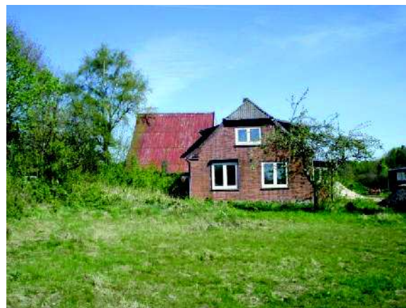
Abb. 9d Abgängiges Wohngebäude eines ehem. landwirtschaftl. Betriebes mit seitlichem Obstgarten (2)
